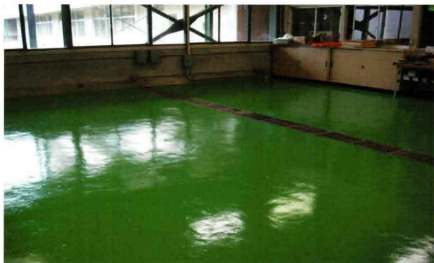
テスト施工結果（場所：大学の作業所）
