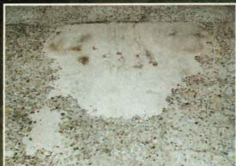
部分穴埋め施工
