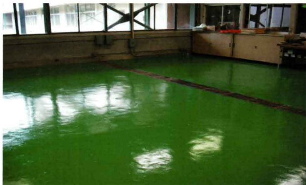
テスト施工結果（場所：大学の作業所）
