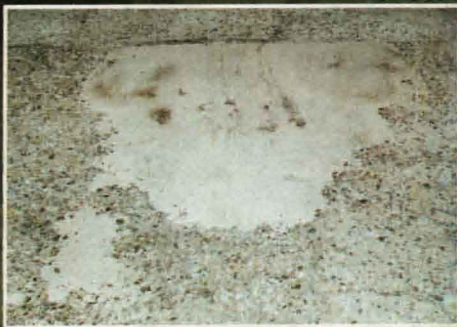
部分穴埋め施工
